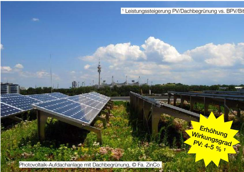
**Erhöhung Wirkungsgrad PV: 4-5 %<sup>1</sup>**
